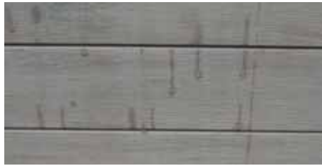
Fleckenbildung durch von Regen angelöste Partikel
